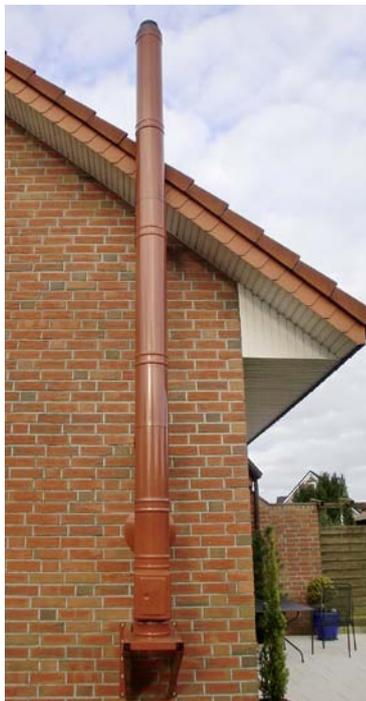
▲ Die Edelstahl-Außenschornsteine können in allen RAL-Farben (hier: RAL Kupferbraun) pulverbeschichtet werden und passen sich so der Fassade an.
